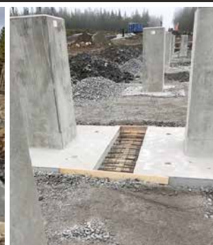
Montage av prefabfundament
